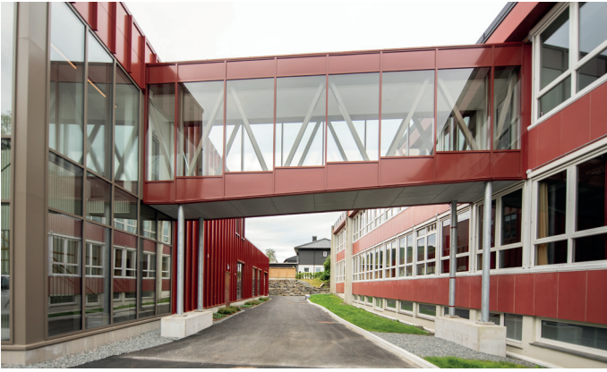
Idrettshallen er forbundet med skolebygget via en gangbru.
