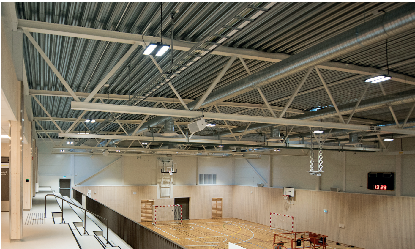
Taket i hallen bæres av 24 meter lange fagverksbjelker av stål.
