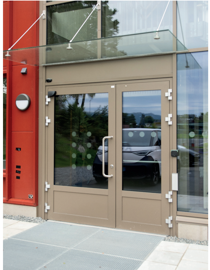
Hovedinngang med beskyttelse mot nedbør.
